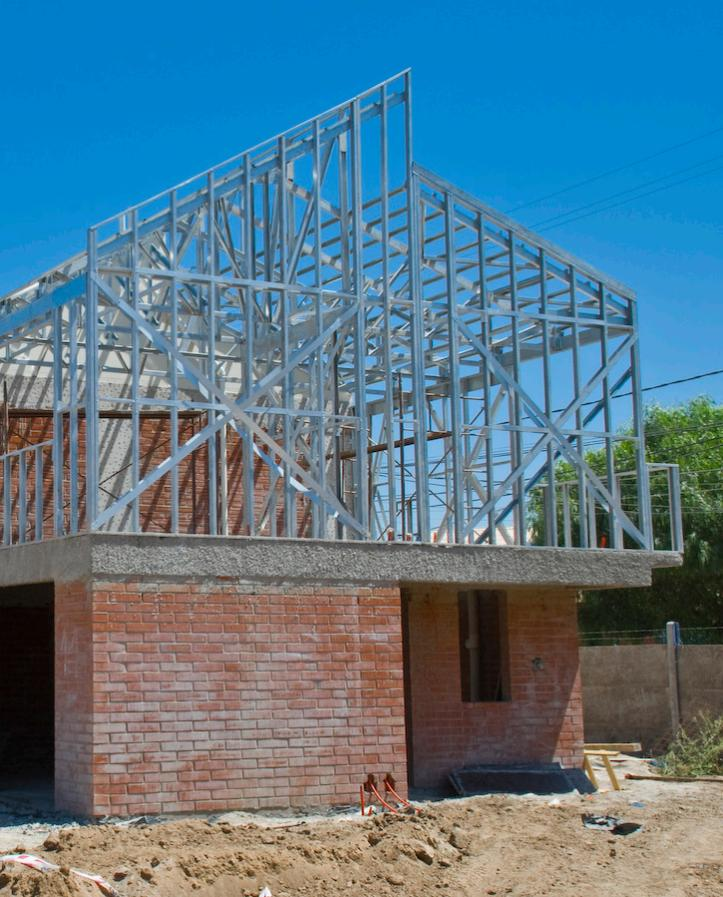
Es un sistema que se compone de perfiles de acero galvanizado estructural, utilizado ampliamente para aplicaciones estructurales, tabiques de división y construcción de cielos. Las principales ventajas de este sistema respecto a otras materialidades tradicionales es que en general es más liviano, rápida instalación, simple y no se pudre.
